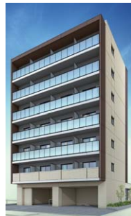
賃貸マンション開発事業 (プレイズシード桜山) 2018年2月竣工
