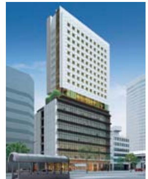
2018年6月建築工事着工
