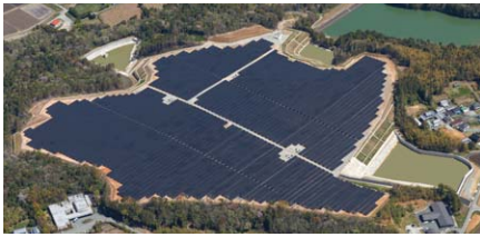
大仏山メガソーラー発電所
